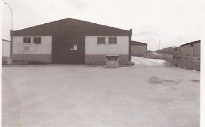
Nave de la cooperativa «El Cajilón»
