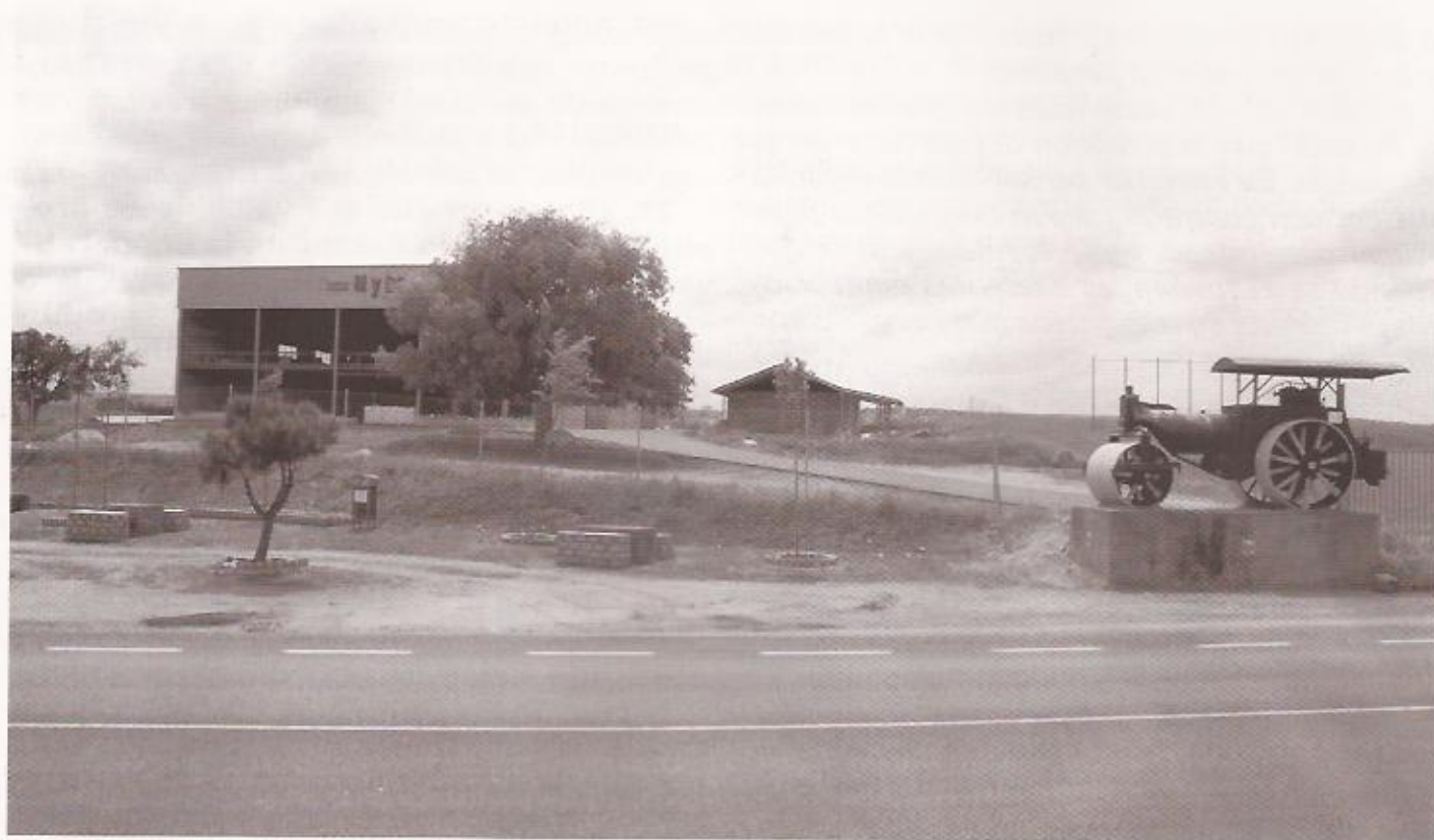
Nave de Muebles MyDO con licencia Municipal en suelo no urbanizable.
