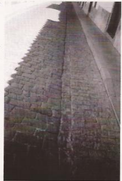
C/ Iglesia, 20-8-05. Acerado con sus bordillos
