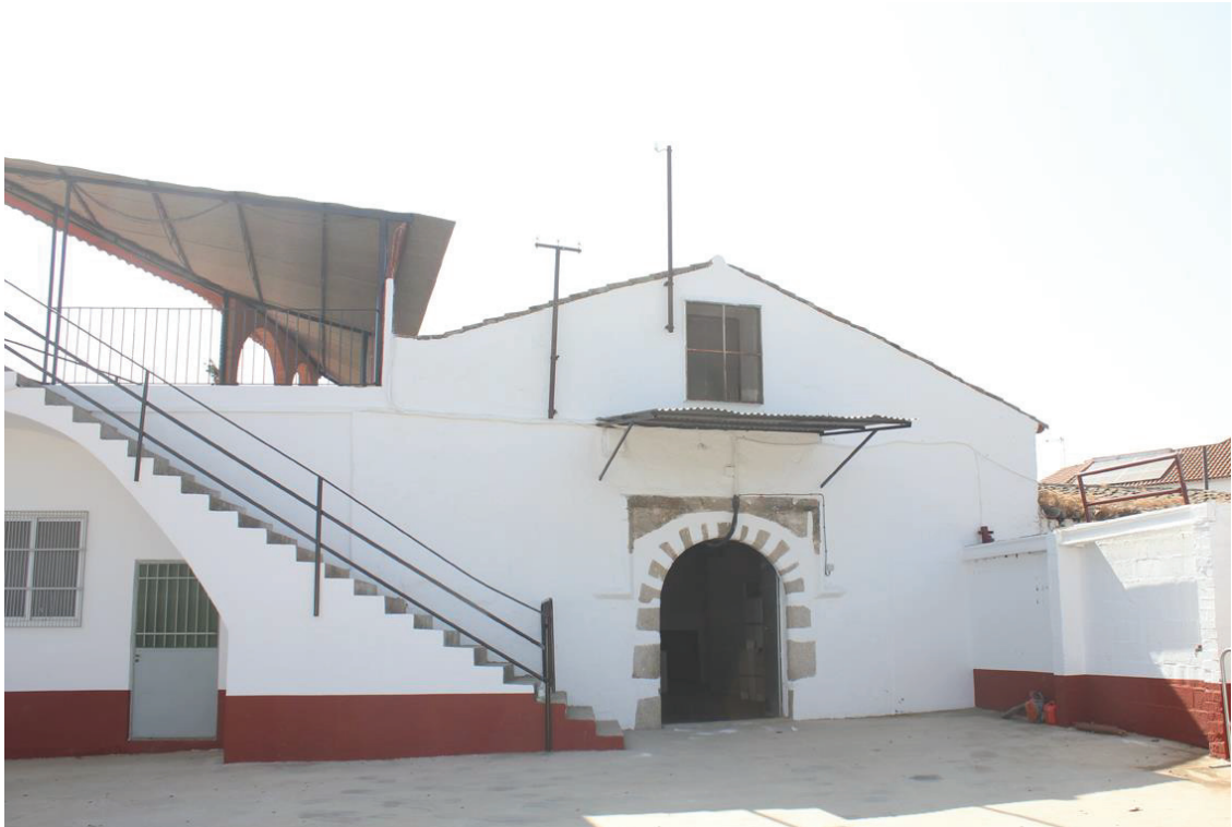
Ermita de San Roque de Torre Franca en la actualidad, formando parte de los edificios anexos (almacenes y chiqueros) de la Plaza de Toros de Dos Torres.
