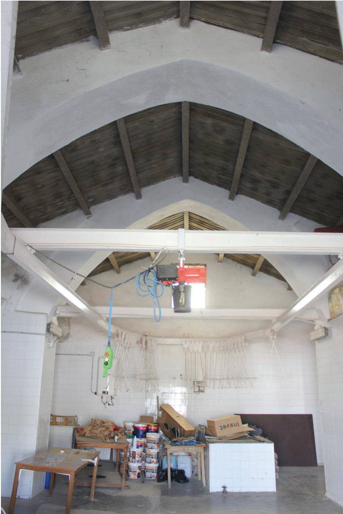
Interior de la antigua ermita de San Roque de Torre Franca, en la actualidad utilizada como almacén municipal. Pueden verse las vigas de hierro y los ganchos de colgar las reses que se mantienen como recuerdo de su anterior uso como matadero.
