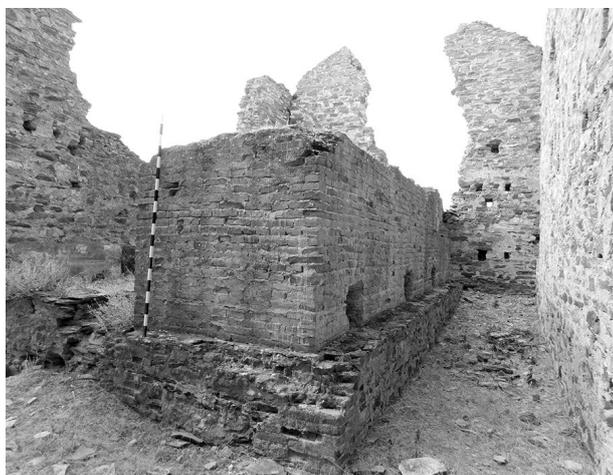
Figura 11. Mina La Solana: Bloque para el asiento de la máquina Hathorn Davey.
