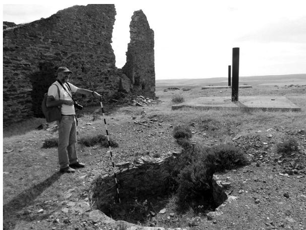
Figura 12. Mina La Solana: Foso para el cabrestante al norte del pozo Toro (cubierto).
