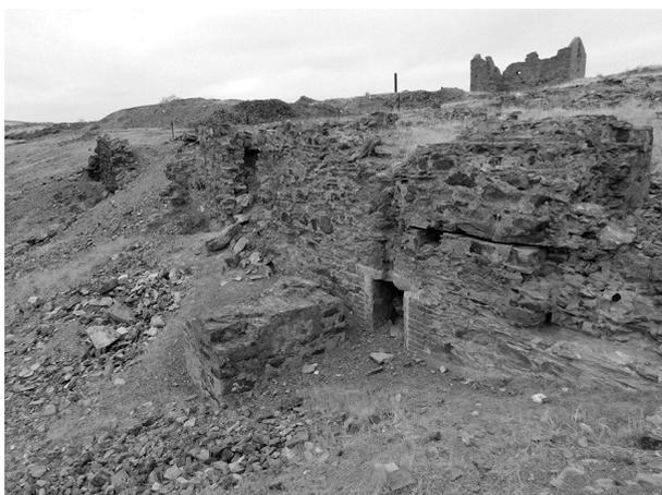
Figura 9. Mina La Solana: Muro posterior de la planta de procesamiento del siglo XIX. El asiento para la quebrantadora está en el centro de la fotografía.
